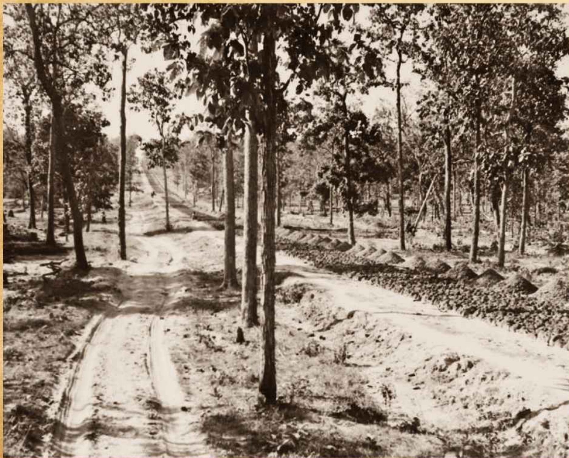
การวางหินเรียงเป็นพื้นถนนสายขอนแก่น - ศรีฐาน (ภูกระดึง) บริเวณกิโลเมตรที่ 27 - 28 ถ่ายเมื่อวันที่ 1 มกราคม พ.ศ. 2482 Broken rocks placed as foundation for the Khon Kaen - Si Than (Phu Kradung) Road at Km.27 - 28. The photograph was taken on January 1, 1940 Credit : เจ้ากาวิละวงศ์ ณ เชียงใหม่
