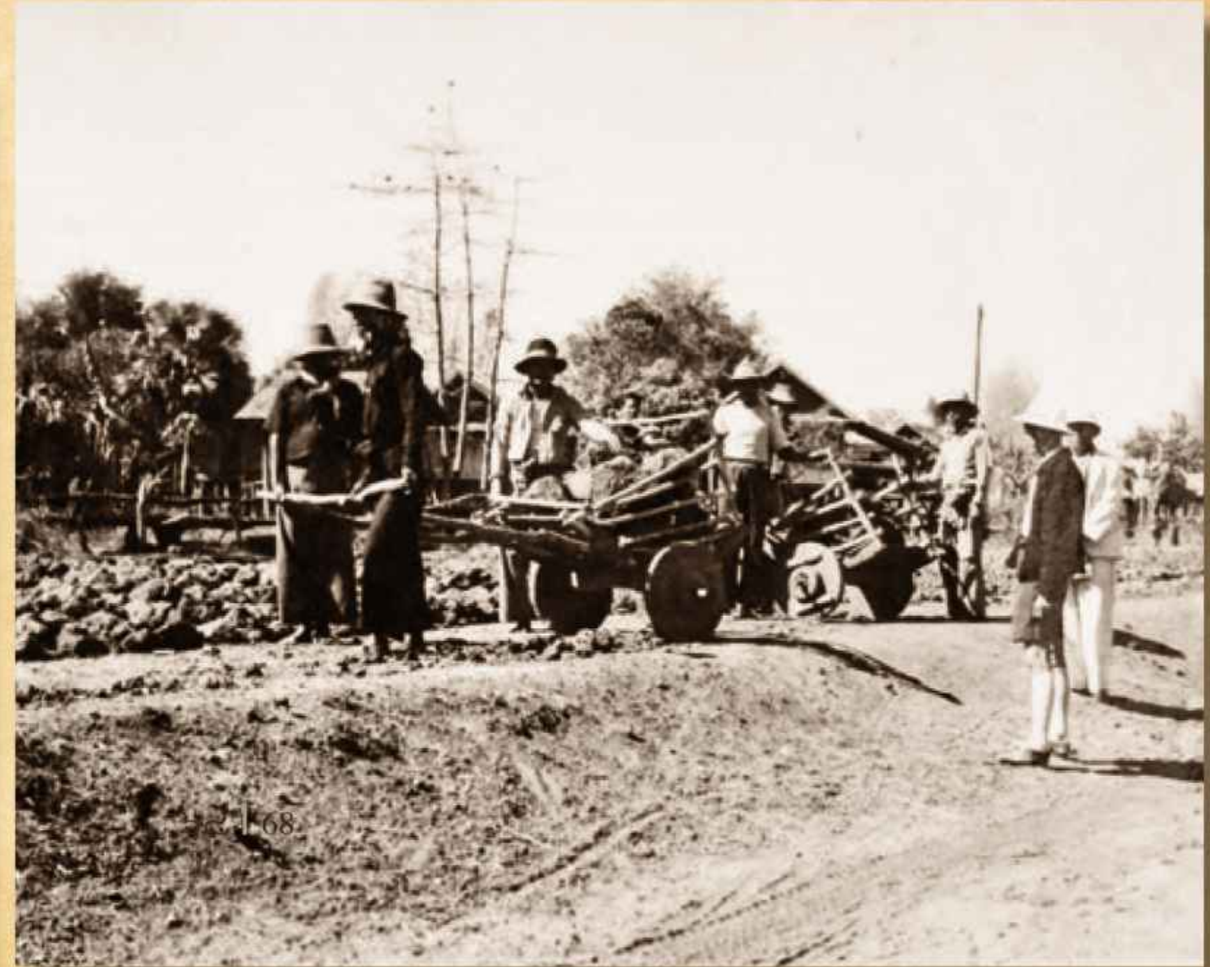
การขนย้ายหินดานที่นำมาเรียงเป็นพื้นถนนในเส้นทางสายอุดรธานี - สกลนคร (ปัจจุบันคือทางหลวงหมายเลข 22 ถนนนิตโย) ถ่ายเมื่อวันที่ 29 มกราคม พ.ศ. 2481
