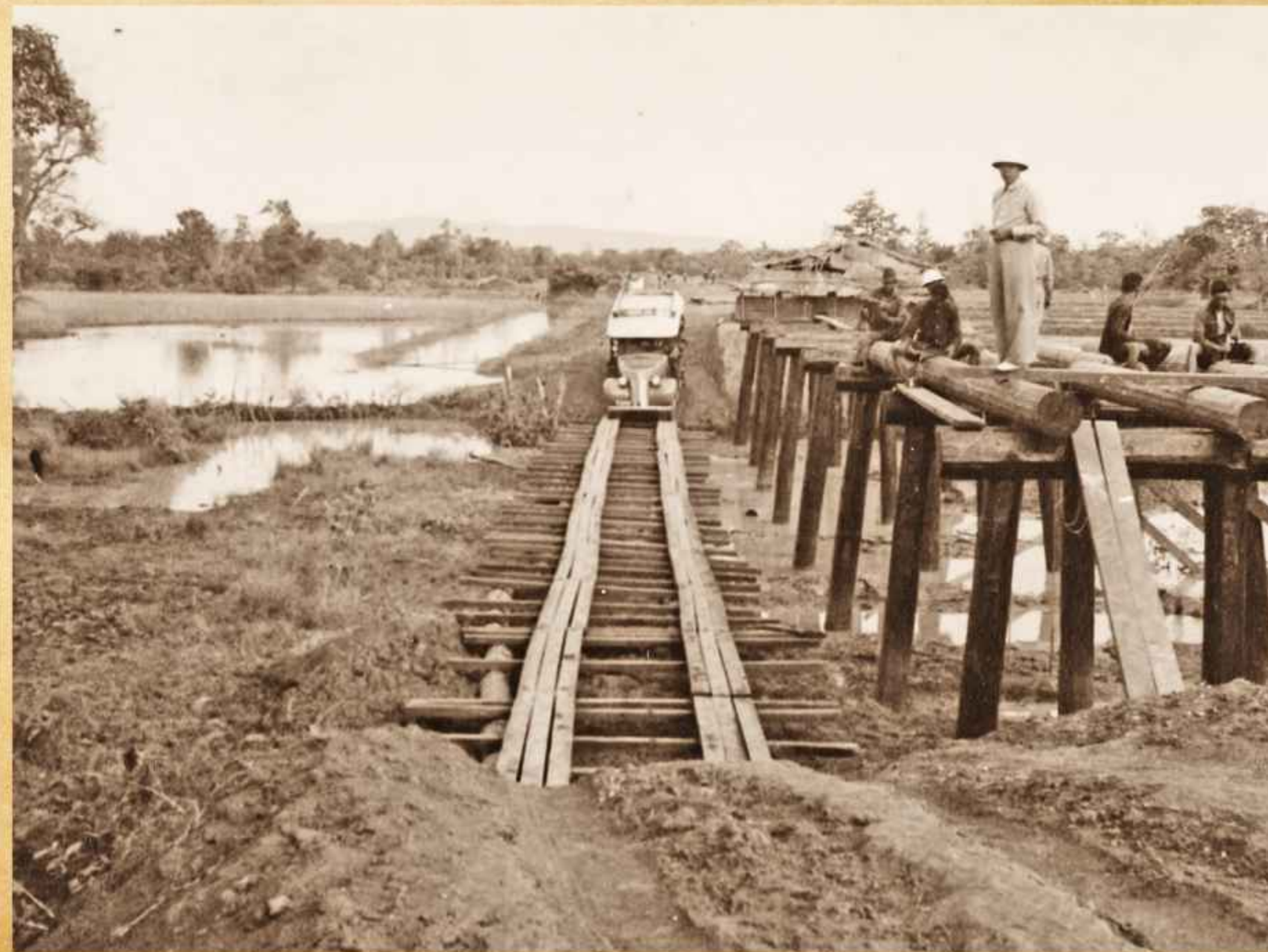
การบูรณะซ่อมแซมสะพานไม้ภายหลังเกิดอุทกภัย เส้นทางสายชัยภูมิ - บัวใหญ่ ระหว่างวันที่ 8 - 9 พฤศจิกายน พ.ศ. 2482 Bridge Repair and Maintenance ,November 8-9,1839 Chaiyaphum - Bua Yai Credit : เจ้ากาวิละวงศ์ ณ เชียงใหม่.
