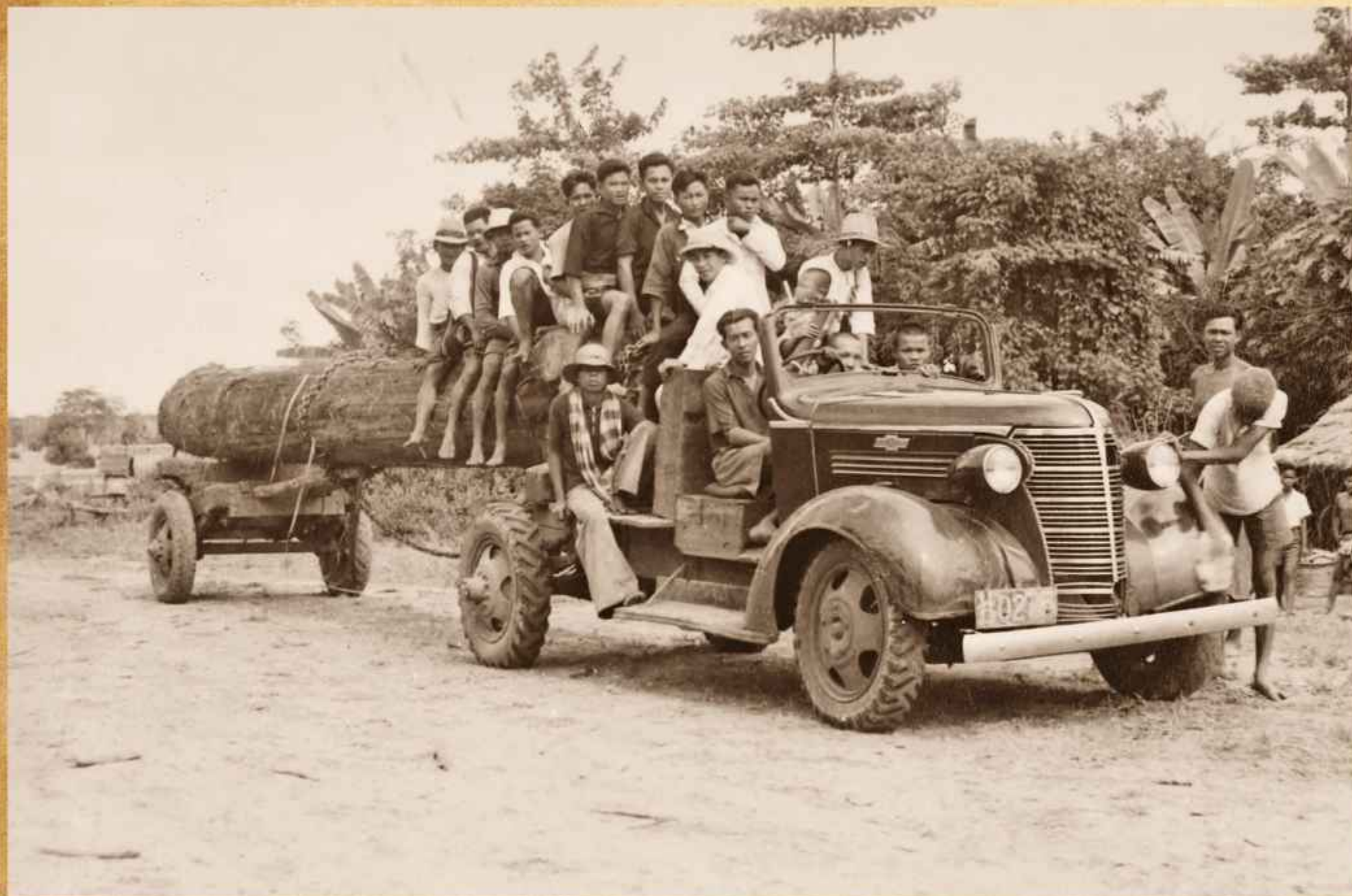
การบูรณะซ่อมแซมสะพานไม้ภายหลังเกิดอุทกภัย เส้นทางสายชัยภูมิ - บัวใหญ่ ระหว่างวันที่ 8 - 9 พฤศจิกายน พ.ศ. 2482
