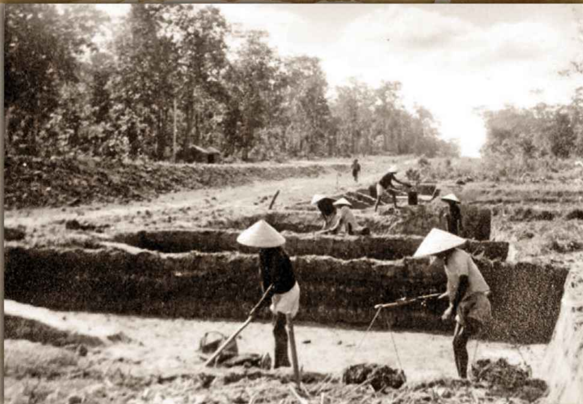
การใช้แรงงานคนเพื่อปรับหน้าดินขึ้นรูปคันทางในการสร้างเส้นทางสายมุกดาหาร - นครพนม (ปัจจุบันคือทางหลวงหมายเลข 212 ถนนชยางกูร) เป็นการสร้างถนนอย่างสมัยใหม่ยุคบุกเบิกในพื้นที่ห่างไกล ถ่ายเมื่อวันที่ 10 มกราคม พ.ศ. 2481
