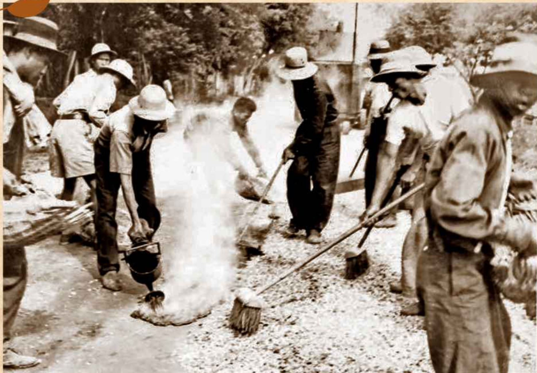
การทดลองลาดยางมะตอยในการสร้างถนนที่ตัวอำเภอบ้านไผ่ จังหวัดขอนแก่น ถ่ายเมื่อเดือนมิถุนายน พ.ศ. 2484
