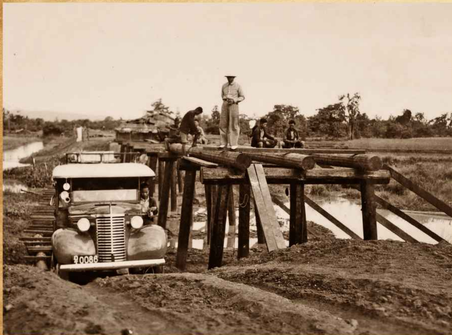
การบูรณะซ่อมแซมสะพานไม้ภายหลังเกิดอุทกภัย บริเวณสะพานห้วยหนองโคก ถนนสายชัยภูมิ - บัวใหญ่ กิโลเมตรที่ 23 ระหว่างวันที่ 8 - 9 พฤศจิกายน พ.ศ. 2482 Bridge Repair and Maintenance ,November 8-9,1839 Chaiyaphum - Bua Yai Credit : เจ้ากาวิละวงศ์ ณ เชียงใหม่
