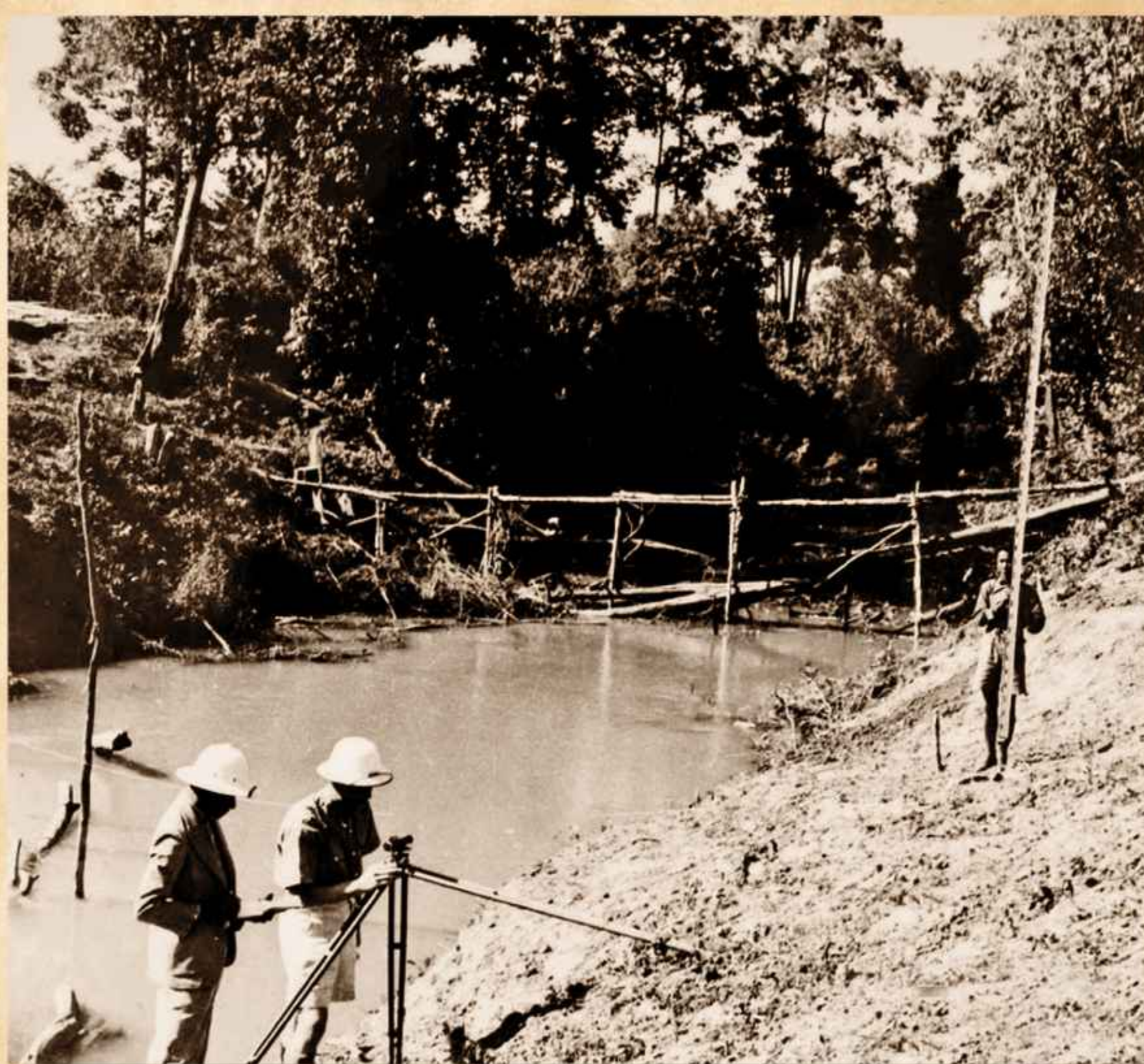
การสำรวจส่องกล้องของนายช่างกองทางกรมทางหลวง ในการสร้างสะพานข้ามลำน้ำเชิญ อำเภอหนองเรือ จังหวัดขอนแก่น บนเส้นทางสายขอนแก่น - เลย์ (ปัจจุบันเป็นส่วนหนึ่งของทางหลวงหมายเลข 12 ถนนมลิวรรณ) ถ่ายเมื่อเดือนตุลาคม พ.ศ. 2484
