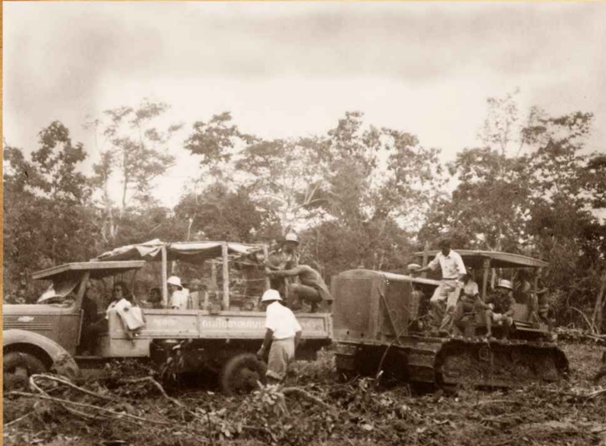
การสำรวจความคืบหน้าในระหว่างการสร้างเส้นทางสาย สี่คิ้ว - บ้านเพชร คือเส้นทางจากอำเภอสี่คิ้ว จังหวัดนครราชสีมา มายังตำบลบ้านเพชร อำเภอบำเหน็จณรงค์ จังหวัดชัยภูมิ ระหว่างวันที่ 31 สิงหาคม - 4 กันยายน พ.ศ. 2482
